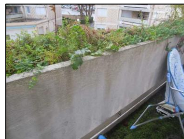
Photo N° 155 ECH-N°009B Bâtiment 3-2ème-Appartement 3025 Balcon – APT3025 - Bac Peinture + béton
