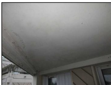
Photo N° 703 ECH-N°149B Bâtiment 28-3ème-Appartement 28031 Balcon – APT28031 – Plafond Peinture + béton
