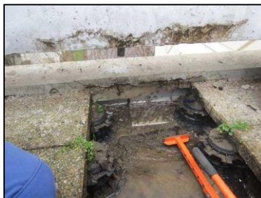
Photo N° 21 ECH-N°020 Bâtiment 1-4ème-Appartement 1041 Terrasse Paxalu
