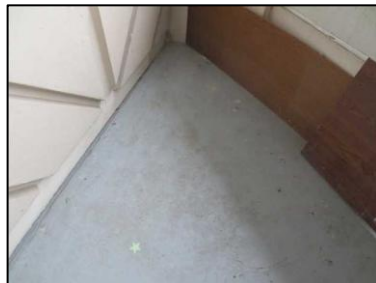
Photo N° 105 ECH-N°104B Bâtiment 30-3ème-Appartement 30035 Balcon – APT30035 – Sol Peinture + béton
