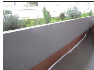
Photo N° 166 ECH-N°020B Bâtiment 7-1er-Appartement 7011 Balcon – APT7011 – Bac Peinture + béton
