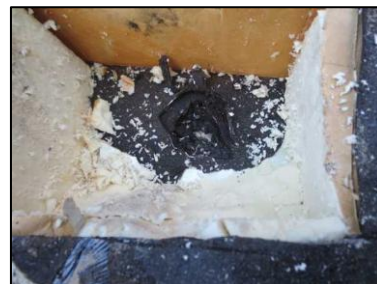
Photo N° 205 ECH-N°040 -- Appartement 3015 Terrasse – Etanchéité sur dalle béton Bitume
