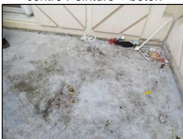
Photo N° 75 ECH-N°073B Bâtiment 21-4ème-Appartement 21041 Balcon – APT21041 – Sol Peinture + béton
