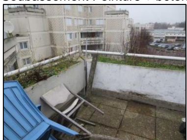
Photo N° 17 ECH-N°016 Bâtiment 1-4ème-Appartement 1041 Terrasse – Bac Béton + peinture
