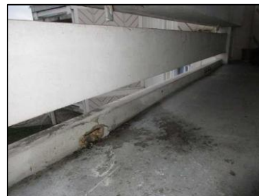
Photo N° 70 ECH-N°006 Bâtiment 19-4ème-Appartement 19042 Terrasse - Etanchéité sur dalle béton Bitume
