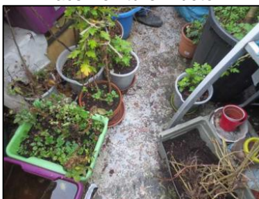
Photo N° 91 ECH-N°089B Bâtiment 30-6ème-Appartement 30062 Balcon – APT30062 – Sol Peinture + béton
