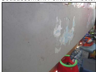
Photo N° 57 ECH-N°055B Bâtiment 19-1er-Appartement 19012 Balcon - APT19012 – Bac Peinture + béton
