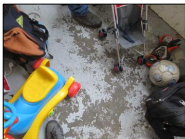
Photo N° 51 ECH-N°049B Bâtiment 30-2ème-Appartement 30024 Balcon – APT30024 – Sol Peinture + béton
