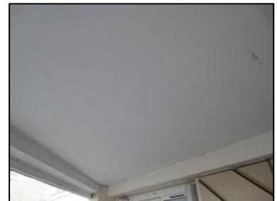
Photo N° 106 ECH-N°105B Bâtiment 30-3ème-Appartement 30035 Balcon – APT30035 – Plafond Peinture + béton
