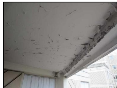
Photo N° 87 ECH-N°085B Bâtiment 19-2ème-Appartement 19025 Balcon - APT19025 – Plafond Peinture + béton
