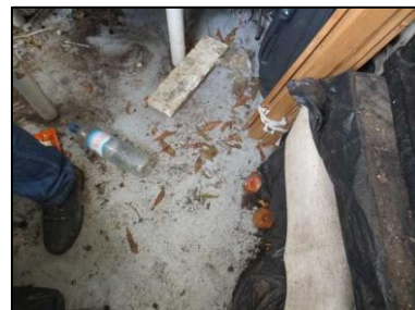
Photo N° 141 ECH-N°140B Bâtiment 5-3ème-Appartement 5031 Balcon – APT5031 - Sol Peinture + béton
