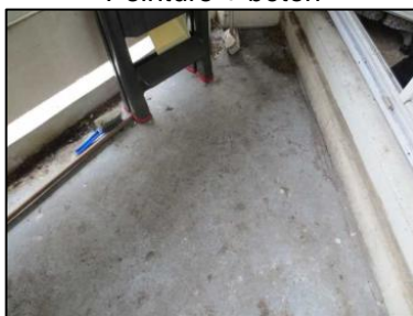
Photo N° 39 ECH-N°037B Bâtiment 28-3ème-Appartement 28035 Balcon – APT28035 – Sol Peinture + béton
