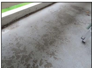
Photo N° 172 ECH-N°026B Bâtiment 7-2ème-Appartement 7023 Balcon – APT7023 – Sol Peinture + béton
