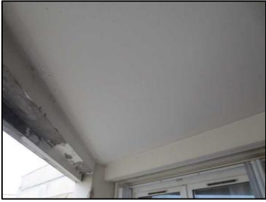
Photo N° 99 ECH-N°097B Bâtiment 3-2ème-Appartement 3023 Balcon – APT3023 – Plafond Peinture + béton
