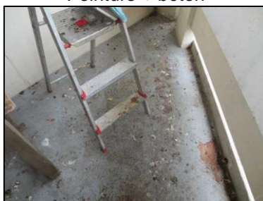
Photo N° 149 ECH-N°003B Bâtiment 32-3ème-Appartement 32034 Balcon - APT32034 – Sol Peinture + béton
