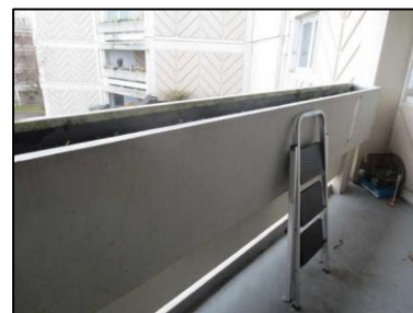
Photo N° 64 ECH-N°062B Bâtiment 32-2ème-Appartement 32021 Balcon – APT32021 – Bac Peinture + béton
