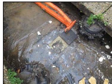
Photo N° 19 ECH-N°018 Bâtiment 1-4ème-Appartement 1041 Terrasse – Etanchéité sur dalle béton Bitume
