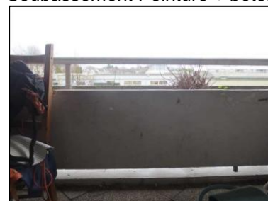
Photo N° 174 ECH-N°028B Bâtiment 5-2ème-Appartement 5024 Balcon – APT5024 – Bac Peinture + béton
