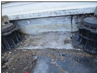
Photo N° 209 ECH-N°044 -- Appartement 5053 Terrasse acrotère – Etanchéité Paxalu
