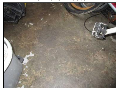
Photo N° 712 ECH-N°158B Bâtiment 1-3ème-Appartement 1035 Balcon – APT1035 – Sol Peinture + béton
