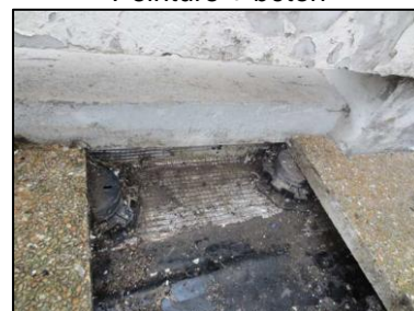
Photo N° 12 ECH-N°011 Bâtiment 30-6ème-Appartement 30063 Terrasse Paxalu
