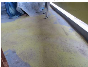
Photo N° 47 ECH-N°045B Bâtiment 30-1er-Appartement 30011 Balcon – APT30011 – Sol Peinture + béton
