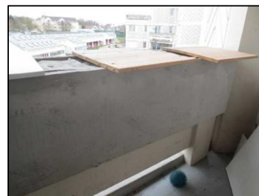
Photo N° 53 ECH-N°051B Bâtiment 19-3ème-Appartement 19034 Balcon - APT19034 – Bac Peinture + béton
