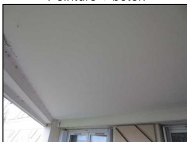
Photo N° 173 ECH-N°027B Bâtiment 7-2ème-Appartement 7023 Balcon – APT7023 – Plafond Peinture + béton
