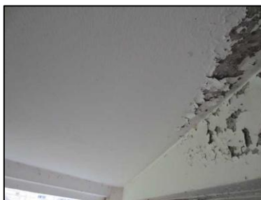
Photo N° 176 ECH-N°030B Bâtiment 5-2ème-Appartement 5024 Balcon – APT5024 – Plafond Peinture + béton
