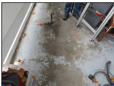
Photo N° 153 ECH-N°007B Bâtiment 1-2ème-Appartement 1022 Balcon - APT1022 – Sol Peinture + béton
