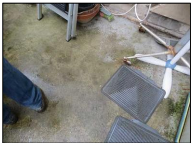
Photo N° 134 ECH-N°133B Bâtiment 7-1er-Appartement 7014 Balcon – APT7014 – Sol Peinture + béton
