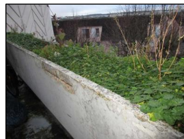
Photo N° 704 ECH-N°150B Bâtiment 28-3ème-Appartement 28033 Balcon – APT28033 – Bac Peinture + béton
