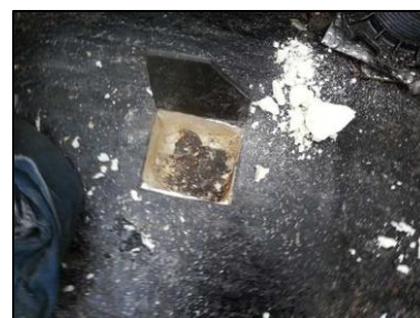
Photo N° 340 ECH-N°035 Bâtiment 21-4ème-Appartement 21043 Terrasse – Etanchéité sur dalle béton Bitume
