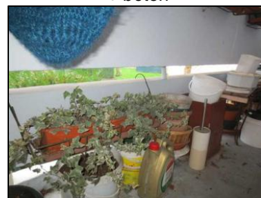
Photo N° 164 ECH-N°017B Bâtiment 1-1er-Appartement 1013 Balcon – APT1013 – Soubassement Peinture + béton
