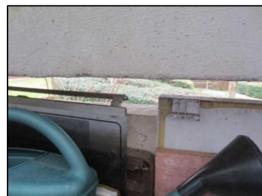
Photo N° 133 ECH-N°132B Bâtiment 7-1er-Appartement 7014 Balcon – APT7014 – Soubassement Peinture + béton
