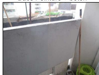
Photo N° 84 ECH-N°082B Bâtiment 19-2ème-Appartement 19025 Balcon - APT19025 – Bac Peinture + béton
