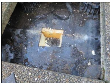
Photo N° 204 ECH-N°039 -- Appartement 3015 Terrasse - Etanchéité Mousse + bitume
