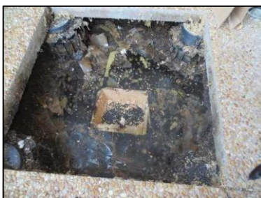
Photo N° 204 ECH-N°039 -- Appartement 3015 Terrasse - Etanchéité Mousse + bitume
