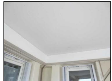
Photo N° 103 ECH-N°101B Bâtiment 30-2ème-Appartement 30022 Balcon – APT30022 – Plafond Peinture + béton
