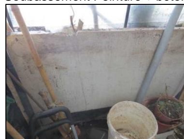
Photo N° 139 ECH-N°138B Bâtiment 5-3ème-Appartement 5031 Balcon – APT5031 – Bac Peinture + béton
