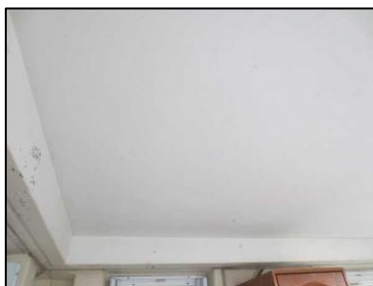
Photo N° 110 ECH-N°109B Bâtiment 30-3ème-Appartement 30033 Balcon – APT30033 – Plafond Peinture + béton
