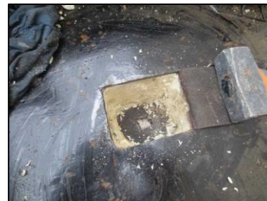
Photo N° 70 ECH-N°006 Bâtiment 19-4ème-Appartement 19042 Terrasse - Etanchéité sur dalle béton Bitume
