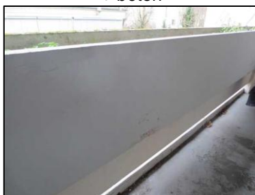
Photo N° 170 ECH-N°024B Bâtiment 7-2ème-Appartement 7023 Balcon – APT7023 – Bac Peinture + béton
