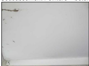
Photo N° 150 ECH-N°004B Bâtiment 32-3ème-Appartement 32034 Balcon - APT32034- Plafond Peinture + béton
