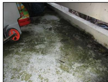
Photo N° 707 ECH-N°153B Bâtiment 28-3ème-Appartement 28033 Balcon – APT28033 – Sol Peinture + béton
