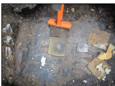
Photo N° 29 ECH-N°028 Bâtiment 7-2ème-Appartement 7022 Terrasse – Etanchéité Mousse + bitume
