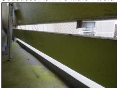
Photo N° 46 ECH-N°044B Bâtiment 30-1er-Appartement 30011 Balcon – APT30011 – Soubassement Peinture + béton
