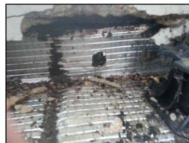
Photo N° 32 ECH-N°032 Bâtiment 32-5ème-Appartement 32052 Terrasse Paxalu
