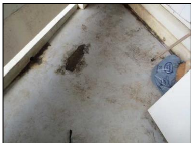
Photo N° 145 ECH-N°144B Bâtiment 7-2ème-Appartement 7025 Balcon – APT7025 – Sol Peinture + béton
