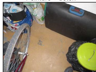
Photo N° 98 ECH-N°096B Bâtiment 3-2ème-Appartement 3023 Balcon – APT3023 – Sol Peinture + béton
