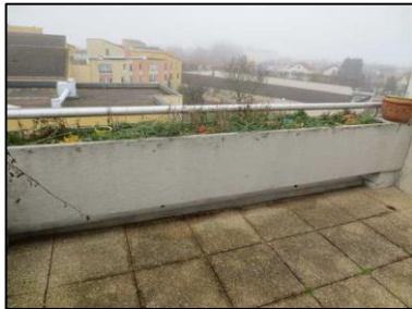
Photo N° 1 ECH-N°001 Bâtiment 19-4ème-Appartement 19042 Terrasse - Bac Béton + peinture
