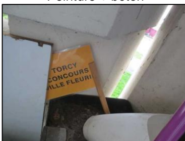
Photo N° 116 ECH-N°115B Bâtiment 21-1er-Appartement 21013 Balcon – APT21013 – Soubassement Peinture + béton
