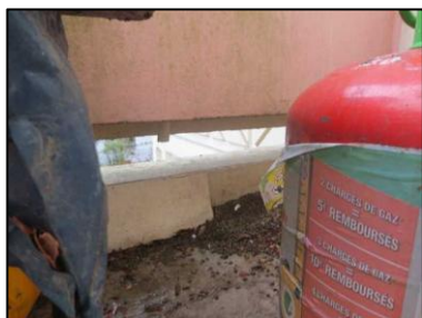
Photo N° 62 ECH-N°060B Bâtiment 32-1er-Appartement 32014 Balcon – APT32014 – Soubassement Peinture + béton
