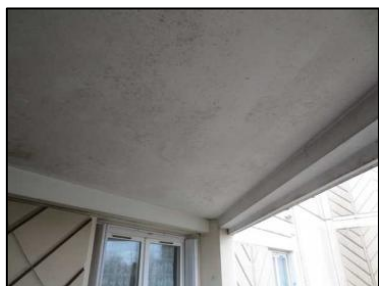
Photo N° 40 ECH-N°038B Bâtiment 28-3ème-Appartement 28035 Balcon – APT28035 – Plafond Peinture + béton
