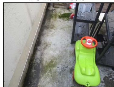
Photo N° 71 ECH-N°069B Bâtiment 21-1er-Appartement 21014 Balcon – APT21014 – Sol Peinture + béton
