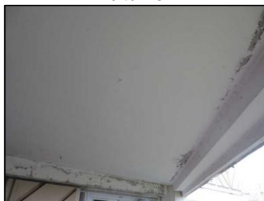
Photo N° 36 ECH-N°034B Bâtiment 5-3ème-Appartement 5033 Balcon – APT5033 – Plafond Peinture + béton
