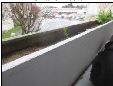
Photo N° 151 ECH-N°005B Bâtiment 1-2ème-Appartement 1022 Balcon – APT1022 - Bac Peinture + béton
