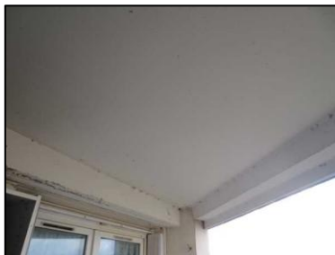
Photo N° 146 ECH-N°145B Bâtiment 7-2ème-Appartement 7025 Balcon – APT7025 – Plafond Peinture + béton
