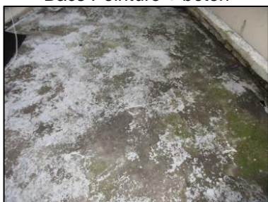
Photo N° 708 ECH-N°154B Bâtiment 28-4ème-Appartement 28042 Balcon – APT28042 – Sol Peinture + béton
