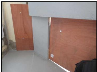
Photo N° 167 ECH-N°021B Bâtiment 7-1er-Appartement 7011 Balcon – APT7011 – Soubassement Peinture + béton
