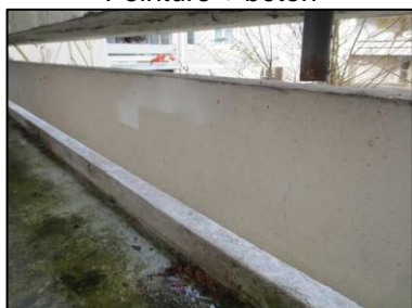
Photo N° 129 ECH-N°128B Bâtiment 7-1er-Appartement 7012 Balcon – APT7012 – Soubassement Peinture + béton
