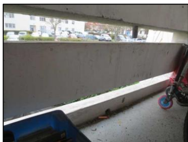
Photo N° 77 ECH-N°075B Bâtiment 21-1er-Appartement 21012 Balcon – APT21012 – Soubassement Peinture + béton
