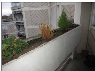
Photo N° 702 ECH-N°146B Bâtiment 28-3ème-Appartement 28031 Balcon – APT28031 – Bac Peinture + béton
