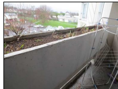
Photo N° 147 ECH-N°001B Bâtiment 32-3ème-Appartement 32034 Balcon – APT32034 - Bac Peinture + béton
