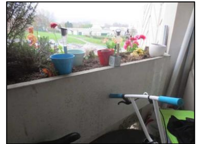
Photo N° 100 ECH-N°098B Bâtiment 30-2ème-Appartement 30022 Balcon – APT30022 – Bac Peinture + béton
