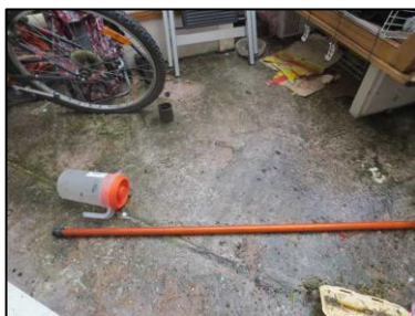
Photo N° 63 ECH-N°061B Bâtiment 32-1er-Appartement 32014 Balcon – APT32014 – Sol Peinture + béton
