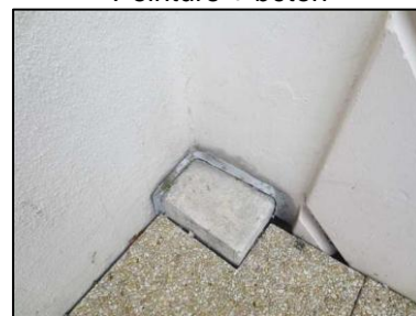
Photo N° 4 ECH-N°003 Bâtiment 19-4ème-Appartement 19042 Terrasse - Joint Mastic
