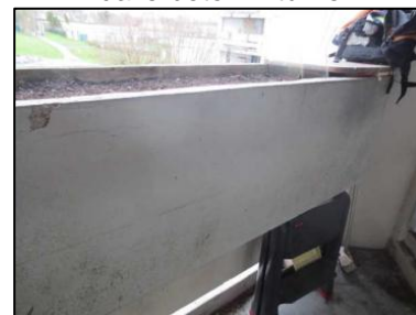
Photo N° 37 ECH-N°035B Bâtiment 28-3ème-Appartement 28035 Balcon – APT28035 – Bac Peinture + béton
