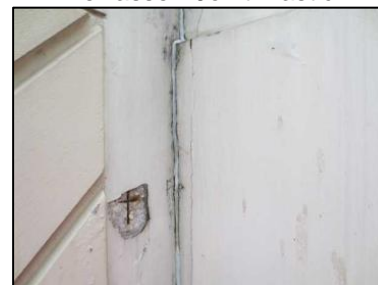
Photo N° 25 ECH-N°024 Bâtiment 7-2ème-Appartement 7022 Terrasse – Joint Mastic
