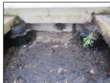
Photo N° 28 ECH-N°027 Bâtiment 7-2ème-Appartement 7022 Terrasse Paxalu
