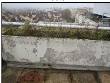
Photo N° 130 ECH-N°012 Bâtiment 30-6ème-Appartement 30063 Terrasse – Bac Béton + peinture
