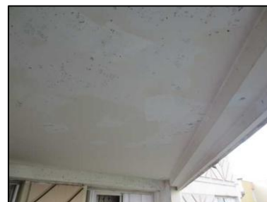
Photo N° 122 ECH-N°121B Bâtiment 19-2ème-Appartement 19023 Balcon - APT19023 – Plafond Peinture + béton
