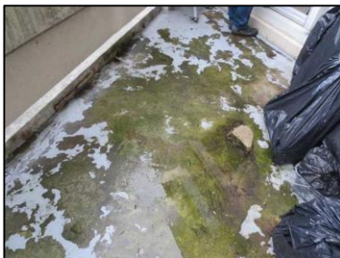
Photo N° 44 ECH-N°042B Bâtiment 28-3ème-Appartement 28034 Balcon – APT2834 – Sol Peinture + béton
