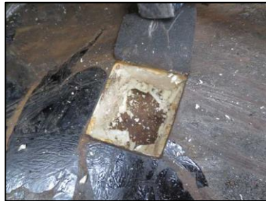
Photo N° 10 ECH-N°009 Bâtiment 30-6ème-Appartement 30063 Terrasse – Etanchéité sur dalle béton Bitume
