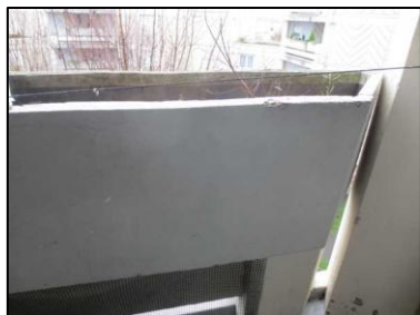
Photo N° 107 ECH-N°106B Bâtiment 30-3ème-Appartement 30033 Balcon – APT30033 – Bac Peinture + béton
