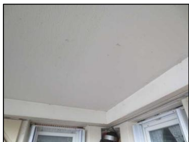
Photo N° 142 ECH-N°141B Bâtiment 5-3ème-Appartement 5031 Balcon – APT5031 – Plafond Peinture + béton
