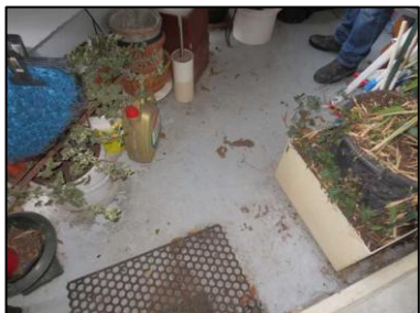
Photo N° 164 ECH-N°018B Bâtiment 1-1er-Appartement 1013 Balcon – APT1013 – Sol Peinture + béton
