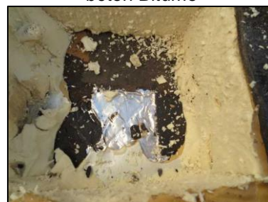
Photo N° 202 ECH-N°037 -- Appartement 28052 Terrasse – Etanchéité sur dalle béton Bitume
