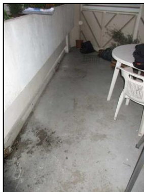
Photo N° 700 ECH-N°148B Bâtiment 28-3ème-Appartement 28031 Balcon – APT28031 – Sol Peinture + béton
