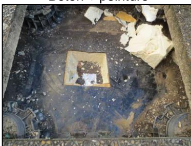
Photo N° 201 ECH-N°036 -- Appartement 28052 Terrasse - Etanchéité Mousse + bitume
