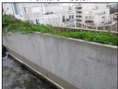
Photo N° 710 ECH-N°156B Bâtiment 28-4ème-Appartement 28042 Balcon – APT28042 – Bac Peinture + béton
