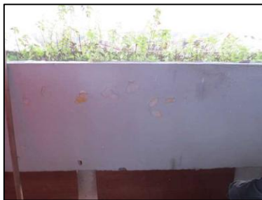
Photo N° 135 ECH-N°134B Bâtiment 5-4ème-Appartement 5042 Balcon – APT5042 – Bac Peinture + béton
