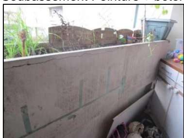
Photo N° 49 ECH-N°047B Bâtiment 30-2ème-Appartement 30024 Balcon – APT30024 – Bac Peinture + béton
