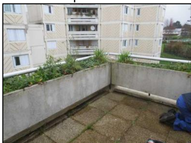
Photo N° 26 ECH-N°025 Bâtiment 7-2ème-Appartement 7022 Terrasse – Bac Béton + peinture
