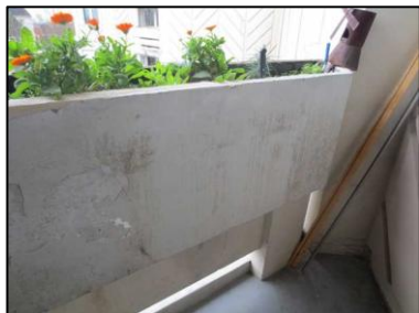
Photo N° 123 ECH-N°122B Bâtiment 1-2ème-Appartement 1021 Balcon - APT1021 – Bac Peinture + béton
