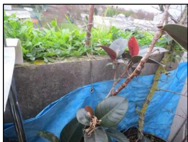
Photo N° 88 ECH-N°086B Bâtiment 30-6ème-Appartement 30062 Balcon – APT30062 – Bac Peinture + béton
