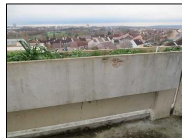
Photo N° 92 ECH-N°090B Bâtiment 3-5ème-Appartement 3054 Balcon – APT3054 – Bac Peinture + béton
