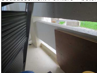
Photo N° 159 ECH-N°013B Bâtiment 3-1er-Appartement 3012 Balcon – APT3012 - Soubassement Peinture + béton
