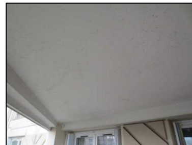
Photo N° 67 ECH-N°065B Bâtiment 32-2ème-Appartement 32021 Balcon – APT32021 – Plafond Peinture + béton
