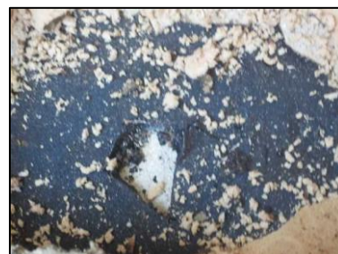
Photo N° 205 ECH-N°040 -- Appartement 3015 Terrasse – Etanchéité sur dalle béton Bitume
