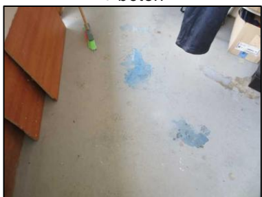
Photo N° 137 ECH-N°136B Bâtiment 5-4ème-Appartement 5042 Balcon – APT5042 – Sol Peinture + béton
