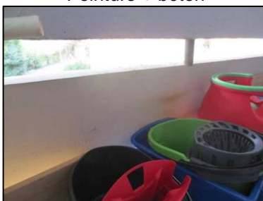
Photo N° 58 ECH-N°056B Bâtiment 19-1er-Appartement 19012 Balcon - APT19012 – Soubassement Peinture + béton
