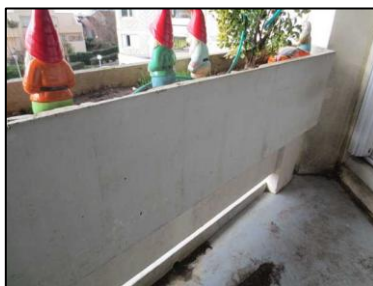
Photo N° 143 ECH-N°142B Bâtiment 7-2ème-Appartement 7025 Balcon – APT7025 – Bac Peinture + béton
