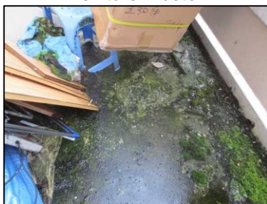
Photo N° 157 ECH-N°011B Bâtiment 3-2ème-Appartement 3025 Balcon – APT3025 – Sol Peinture + béton
