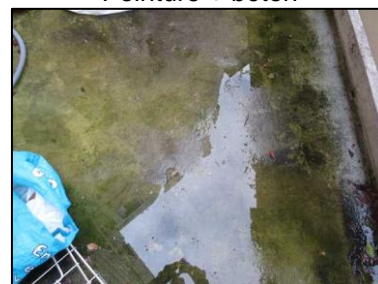
Photo N° 131 ECH-N°129B Bâtiment 7-1er-Appartement 7012 Balcon – APT7012 – Sol Peinture + béton
