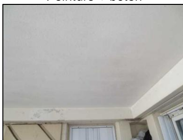
Photo N° 138 ECH-N°137B Bâtiment 5-4ème-Appartement 5042 Balcon – APT5042 – Plafond Peinture + béton
