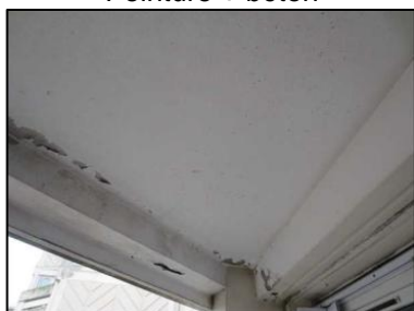
Photo N° 126 ECH-N°125B Bâtiment 1-2ème-Appartement 1021 Balcon - APT1021 – Plafond Peinture + béton
