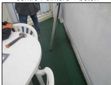
Photo N° 83 ECH-N°081B Bâtiment 19-4ème-Appartement 19041 Balcon - APT19041 – Sol Peinture + béton
