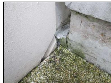
Photo N° 22 ECH-N°021 Bâtiment 1-4ème-Appartement 1041 Terrasse - Joint Mastic
