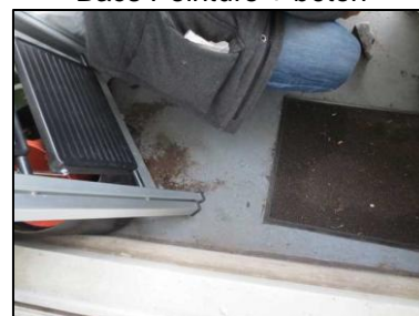
Photo N° 117 ECH-N°116B Bâtiment 21-1er-Appartement 21013 Balcon – APT21013 – Sol Peinture + béton
