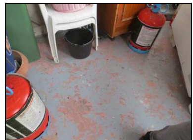
Photo N° 109 ECH-N°108B Bâtiment 30-3ème-Appartement 30033 Balcon – APT30033 – Sol Peinture + béton
