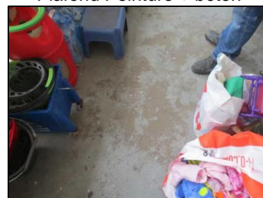
Photo N° 59 ECH-N°057B Bâtiment 19-1er-Appartement 19012 Balcon - APT19012 – Sol Peinture + béton
