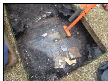
Photo N° 30 ECH-N°029 Bâtiment 7-2ème-Appartement 7022 Terrasse – Etanchéité sur dalle béton Bitume
