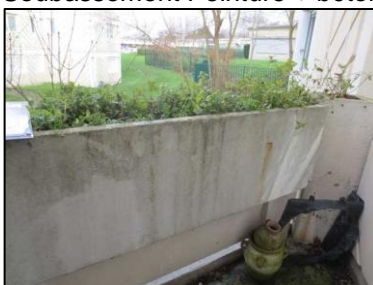
Photo N° 127 ECH-N°126B Bâtiment 7-1er-Appartement 7012 Balcon – APT7012 – Bac Peinture + béton
