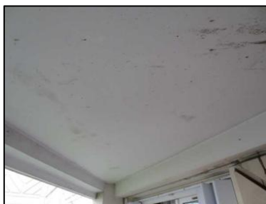
Photo N° 52 ECH-N°050B Bâtiment 30-2ème-Appartement 30024 Balcon – APT30024 – Plafond Peinture + béton
